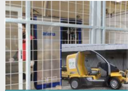
Electrolizador La Poste (Francia) 2015
