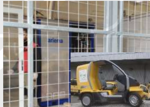
Electrolizador La Poste (Francia), 2015
